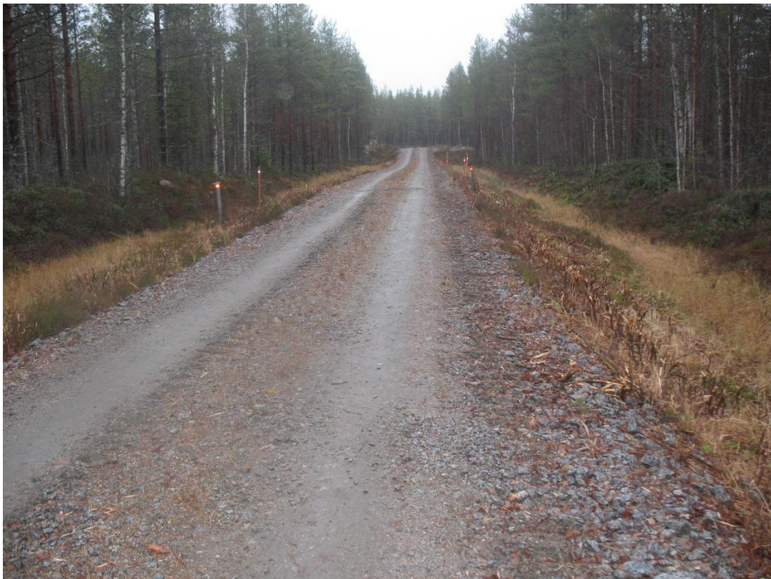
Kuva 1 Vuonna 2011 rakennettu testikohde, jossa rakenteena on noin 30 cm paksu tuhkapatja ja päällä noin 10 cm 0-63 mm sekä 10 cm 0-32 mm kalliomurskekerros. Tie ylittää tällä kohdalla pehmeikön. Kuva otettu 31.10.2018.
