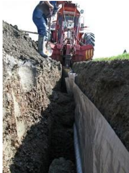
Kuva 12. Periaatekuva lisäveden pumppaamisesta ja muovikalvon sijoittamisesta säätösalaojitetulle happamalle sulfaattimaalle. (Kuva: Rainer Rosendahl)
