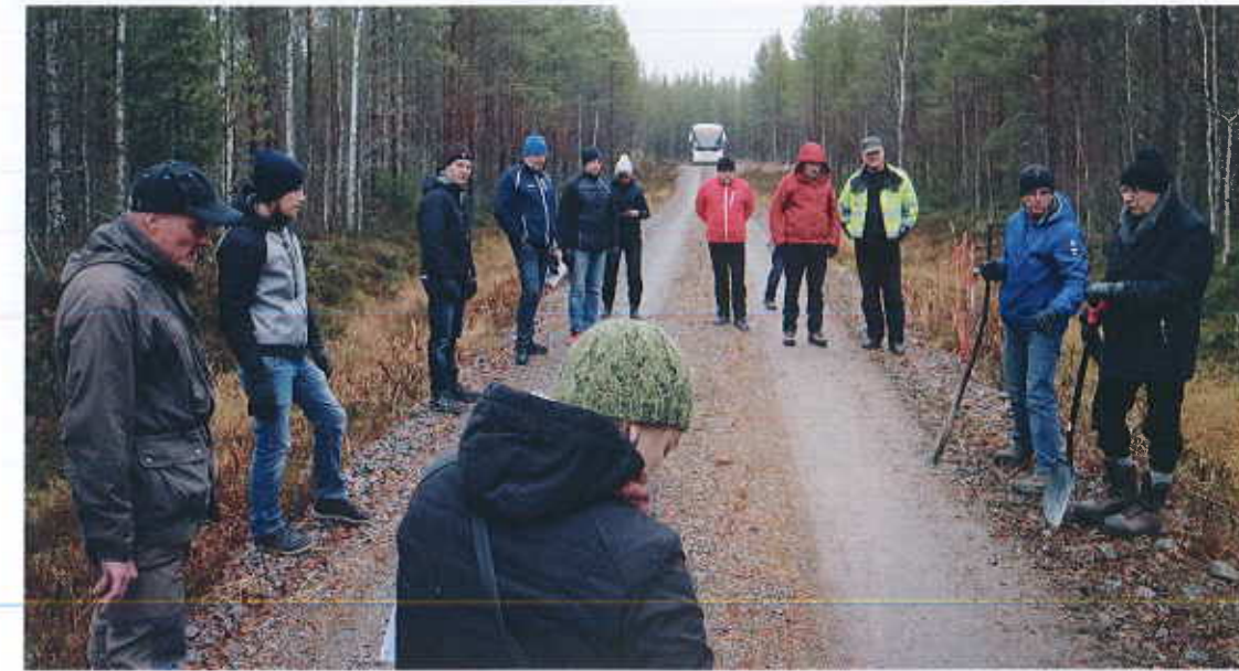
Tuhkamurskeseos muodostaa metsätielle kovan pinnan. Pohjaveden laadun muutoksia mitataan pohjavesiputkien avulla (oikealla).
