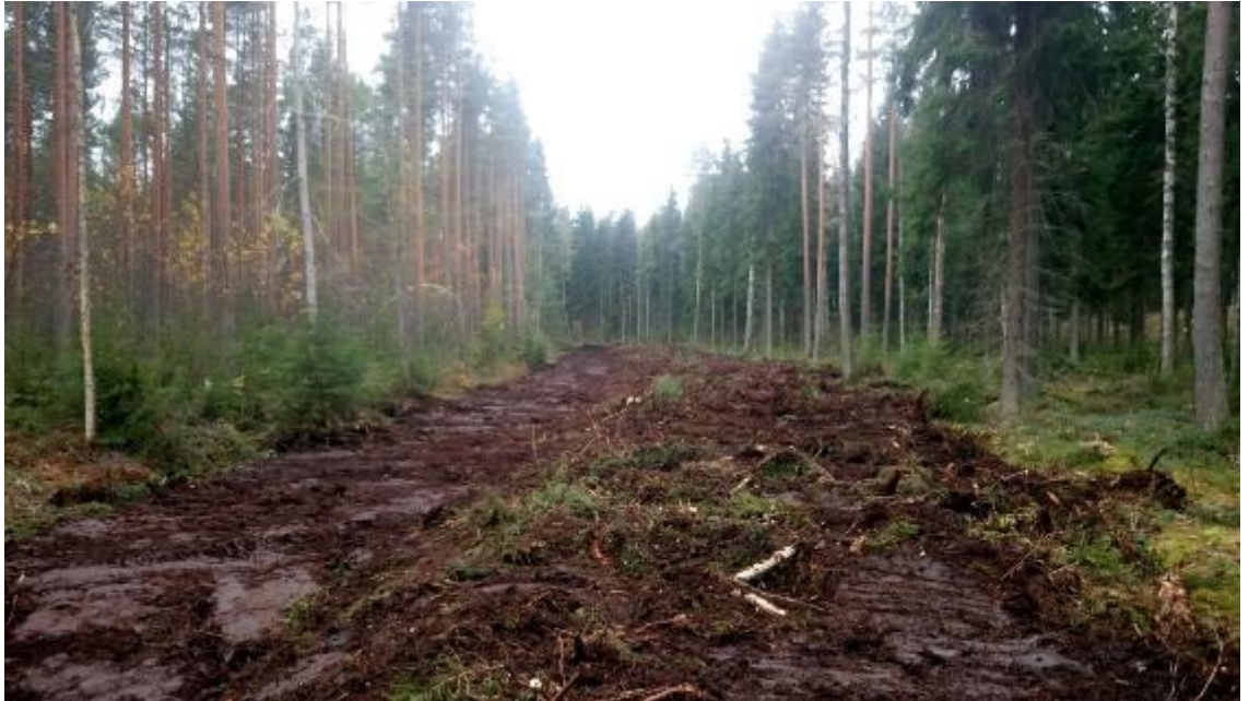
Kuva 11. Valmis tulvatasanne keskivaiheilta
