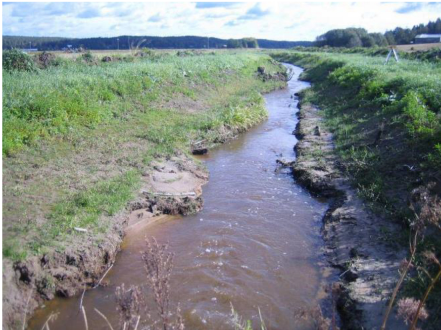
Kuva 5. Syken seurannoissa olevilla kohteilla vähäistä eroosiota on tapahtunut sellaisissa tulvatasanteen kohdissa, joissa ei ole ollut kasvillisuussuojaa. Kuvat: Jukka Jormola
