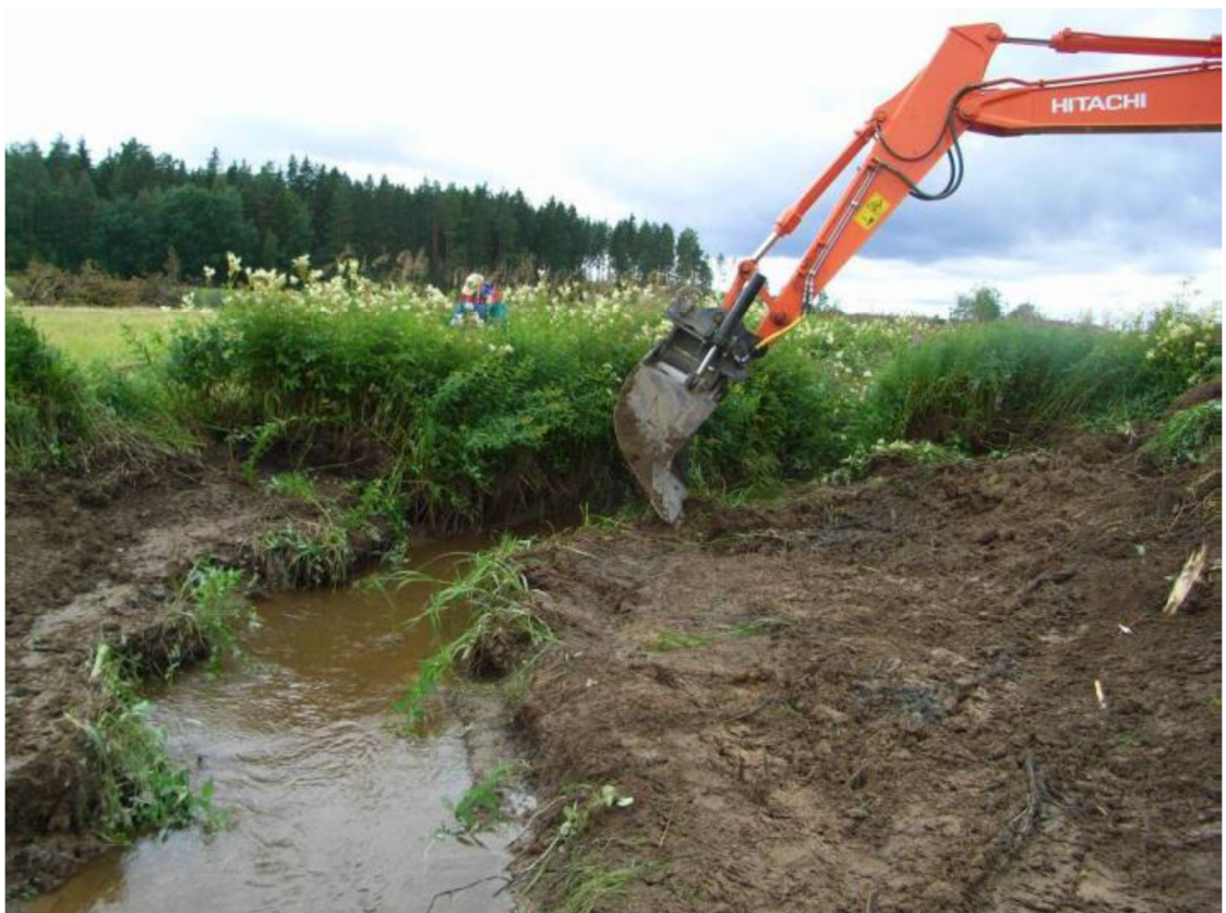
Kuva 3. Kuvasta selviää tulvatasanteen idea maatalouden laskuojassa. Veden levittäytyessä tulva-aikana tulvatasanteelle, veden virtausnopeus heikkenee oleellisesti. Tämä vähentää eroosion vaaraa ja siten kiintoainekuormitusta. Kuva: Kaisa Västilä.
