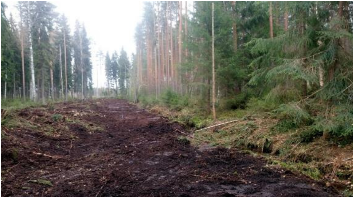
Kuva 12. Valmis tulvatasanne yläpäästä
