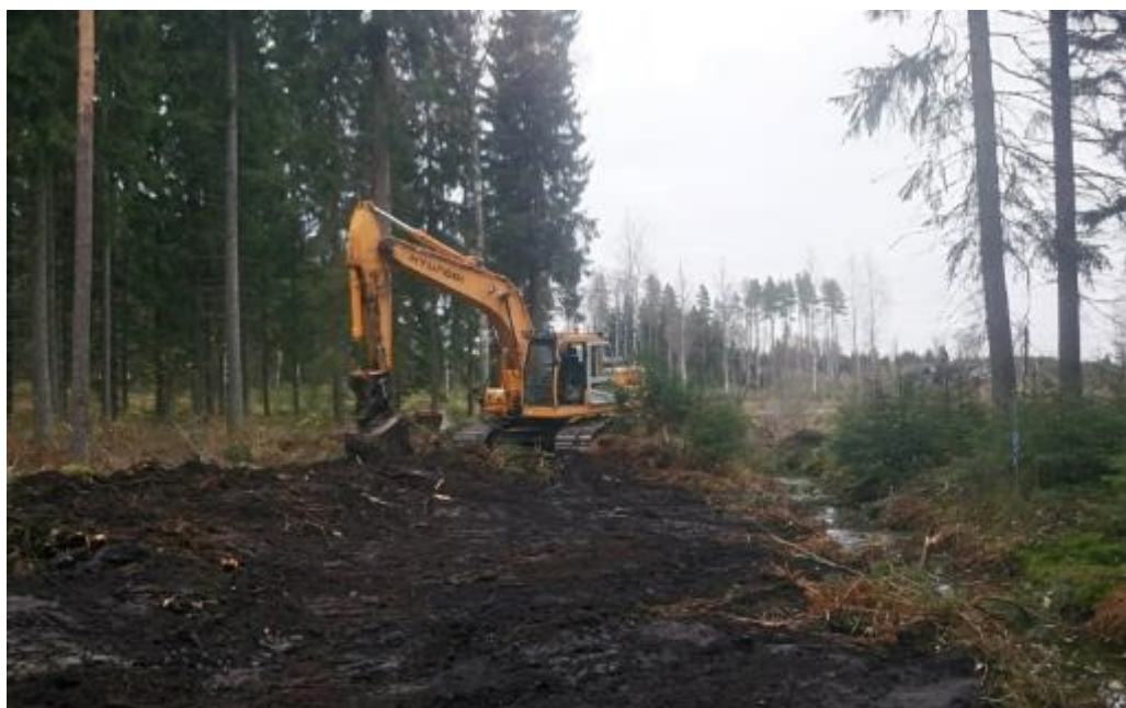
Kuva 10. Valmis tulvatasanne alapäästä
