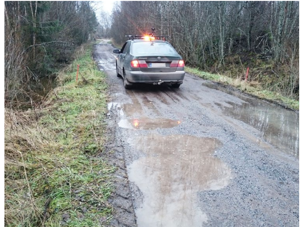
Reunapalle estää veden pääsyn sivuojaan.
