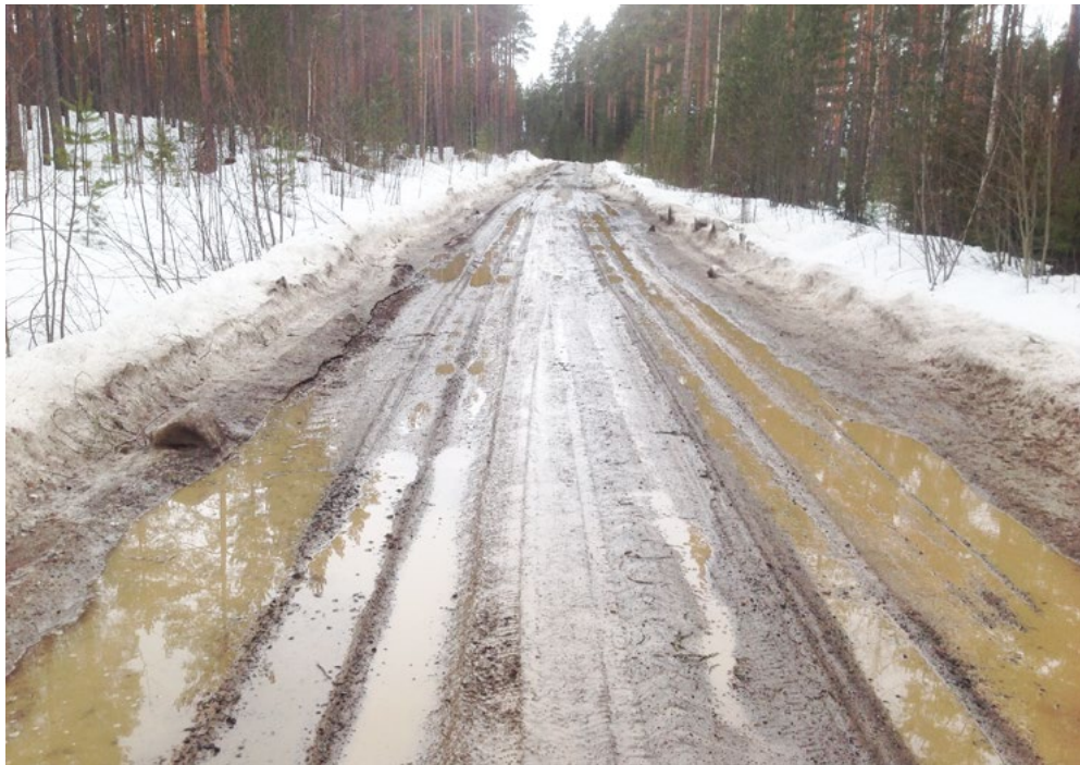
Sama tie samaan aikaan eri kohdista. Oikealla sohjo-ojalla varustettu tie on kantanut kuorman. Vasen on lätäköitynyt ja urautunut
