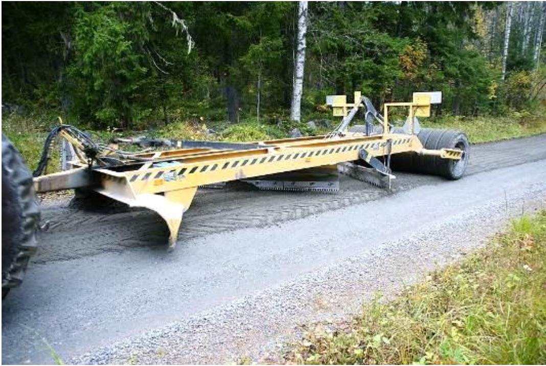
Kuva 25. Metsätien kulutuskerroksen lanausta.
