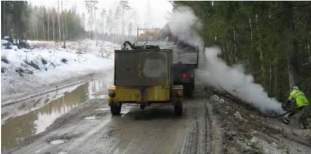
Kuva 35. Rummun sulatusta painehöyryllä.
