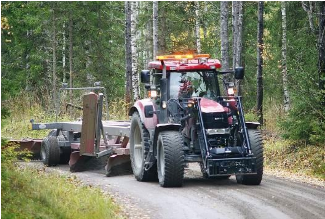
Kuva 26. Metsätien lanausta järeällä kalustolla, lisäsiipi on pystyasennossa.
