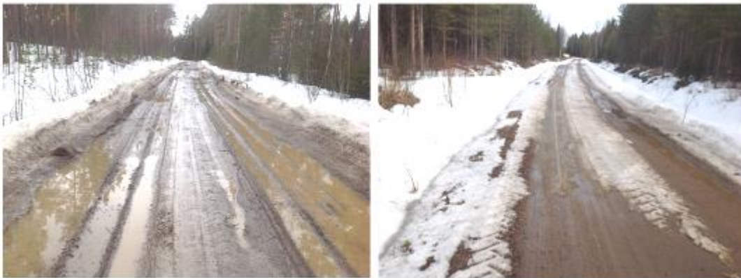
Kuva 24. Sohjo-ojat ehkäisevät sulamisvesien virtaamista ajoradalle. Kuvapari on otettu samaan aikaan saman tien eri kohdista. Vasemmassa kuvassa sohjo-oja ei ole tehty, oikeassa kuvassa on toimittu oikein.
