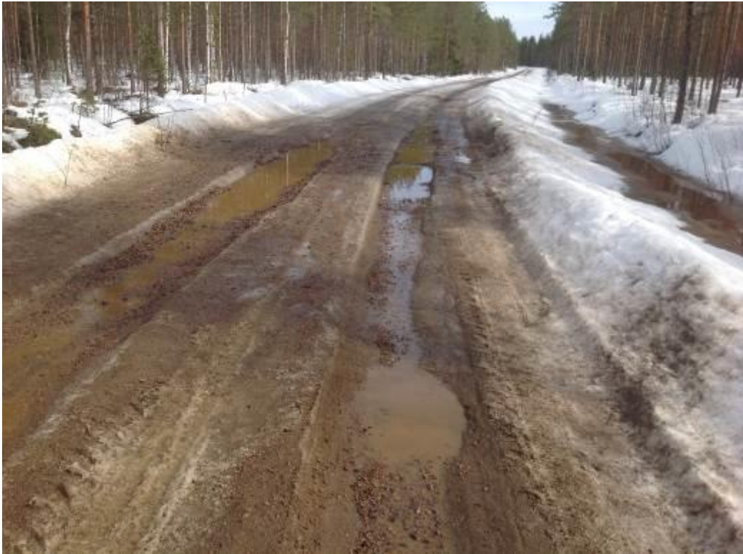
Kuva 13. Sulamisvesien poisjohtamisesta ei ole huolehdittu.
