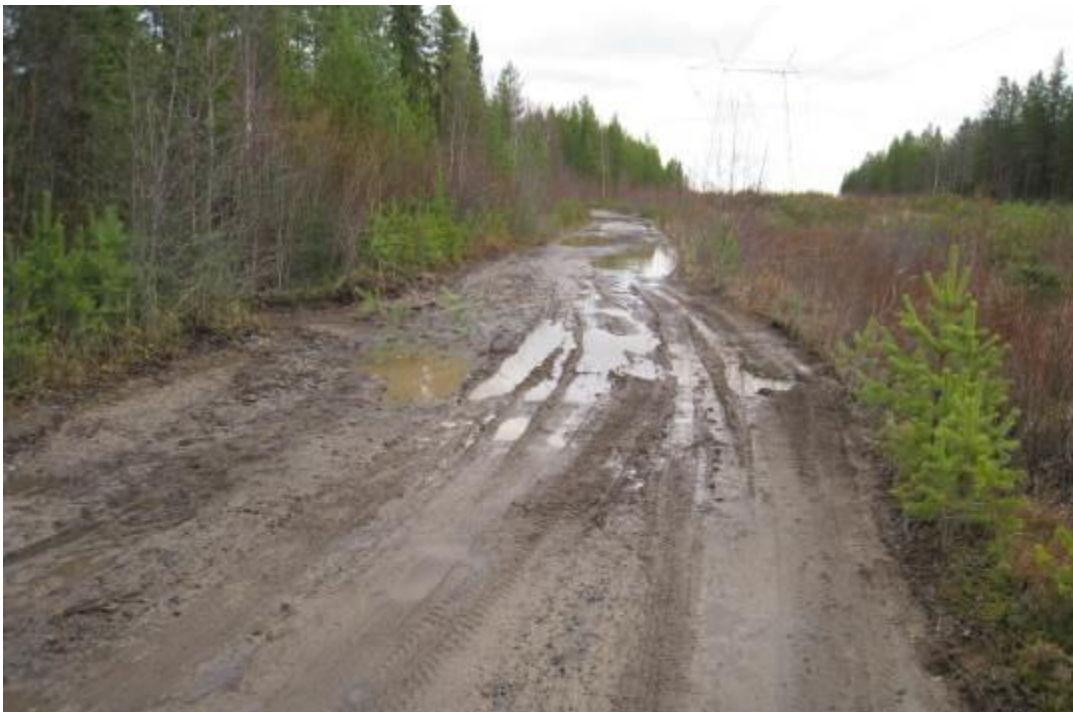
Kuva 15. Runkokelirikkoa metsätiellä.
