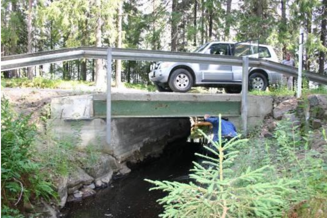
Kuva 38. Silmämääräinen tarkastus kertoo nopeasti sillan yleiskunnosta.
