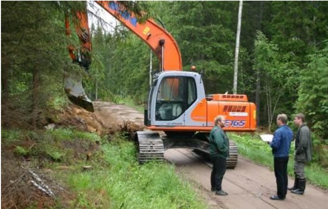
Kuva 39. Tien alusrakenteen parantamiseen kuuluvat rungon muotoilu ja tasoitus, pintakivien poisto, vesakon ja tarvittaessa puuston poisto tien reunoilta sekä ojien kaivu.
