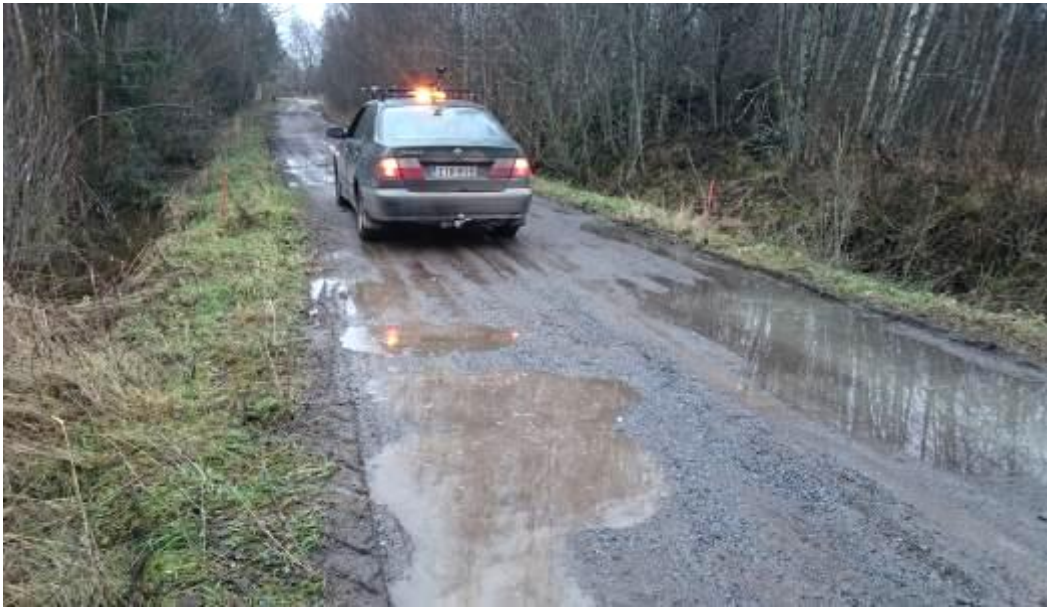
Kuva 14. Reunapalteet estävät veden valumisen ojiin.
