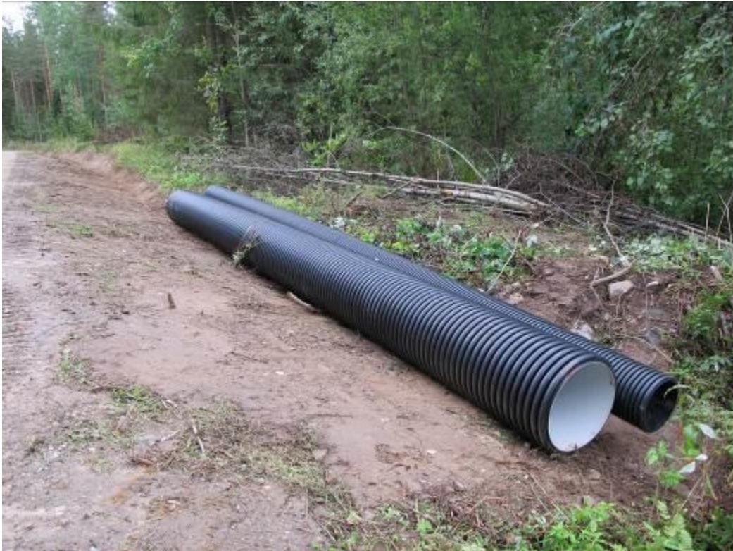
Kuva 34. Tien alle laitettava 400 mm:n rumpu ja 200 mm:n liittymärumpu.
