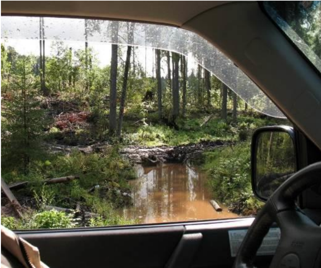
Kuva 32. Ajoura on tukkinut metsätien laskuojan. Tie pehmenee nopeasti, ellei tukosta avata.
