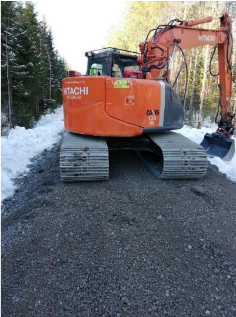
Kuva 15 Kaivuria tarvitaan ketjussa työparina. Työketjussa tarvitaan riittävä määrä kuorma-autoja, kaivuri ja jyrä. Kuormien sopiva väli on noin puoli tuntia. Valmista tuhkatähtä-tierunkoa kaivurityön jäljeltä syntyy noin 25 metriä yhdellä kuormallisella. (Kuva Jenni Nurmi)
