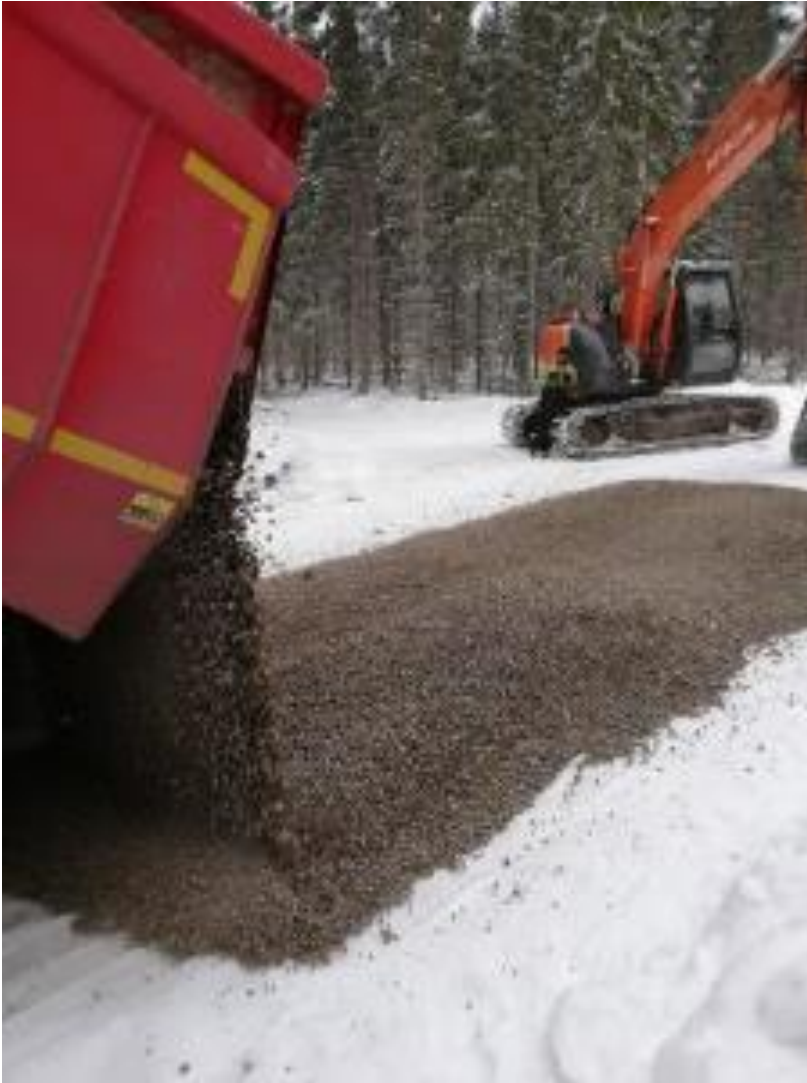
Kuva 13 Tuhkapatja on mahdollista vetää myös matoksi. Talvella jäätyneet kokkareet tulee erotella kuor- masta seulomalla, koska ne haittaavat tuhkan tasaista levitystä. (Kuva Jenni Nurmi)
