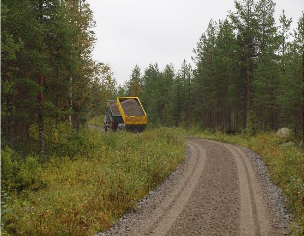
Kuva 9 Kuorma-autosta ja erityisesti kasetista seosmurskeen levitys vaatii kuljettajalta erityistä osaamista. (Kuva Tommi Tenhola)
