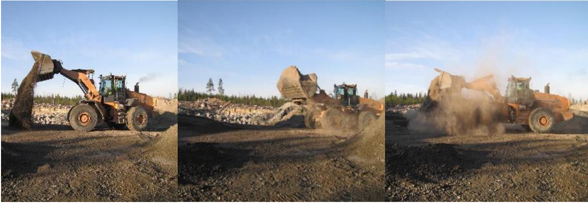
Kuva 8 Tuhkamurskeseoksen valmistamista kauhakuormaajamenetelmällä välivarastolla. (Kuvat Tommi Tenhola)
