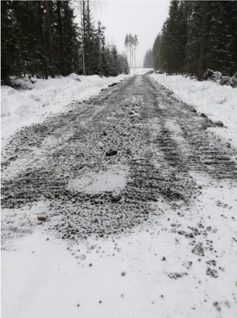
Kuva 12 Suodatinkangas on sidottu ensimmäisillä kuormilla paikalleen ohuella tuhkakerroksella. (Kuva Jenni Nurmi)
