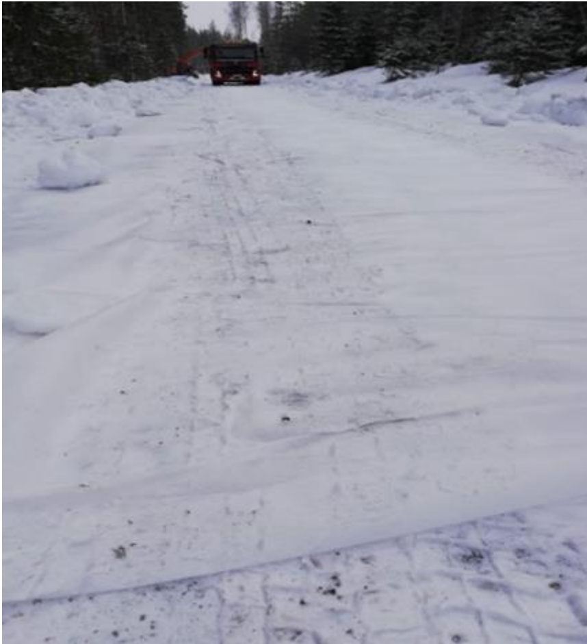
Kuva 11 Pohjalle on laitettu lujuusominaisuuksiltaan kuorma-auton kestävä suodatinkangas. (Kuva Jenni Nurmi)
