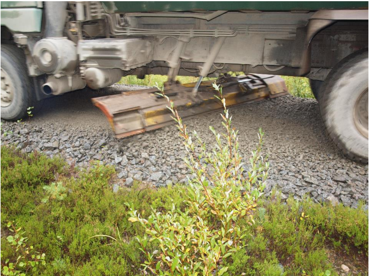
Kuva 10 Tuhkamurskeseoksen tasausta kuorma-auton alusterällä. (Kuva Tommi Tenhola)
