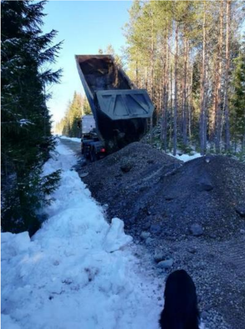
Kuva 14 Seuraavat kuormat on ajettu lyhyelle matkalle läjiin kaivurilla levitettäväksi. (Kuva Jenni Nurmi)
