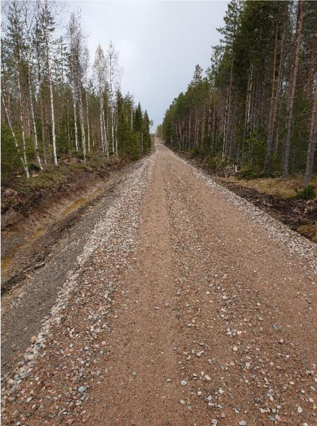
Kuva 17 Tuhkapatjan päälle päällysrakenteeksi on ajettu 10 - 20 cm:n kerros soramursketta. (Kuva Samuli Joensuu)
