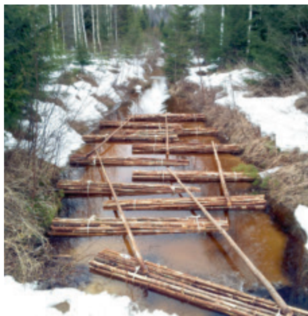
Kuva 2. Kuusirankanippuja esiasennettuna laskeutuslallan jään päälle.
