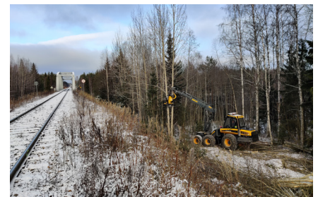
Väyläviraston tilaamassa työssä poistetaan puustoa rautatiealueelta ja suoja-alueelta, hakkuukoneenkuljettajalla on voimassa oleva ratatyöturvallisuuspätevyys rautatiealueella liikkumista varten.
