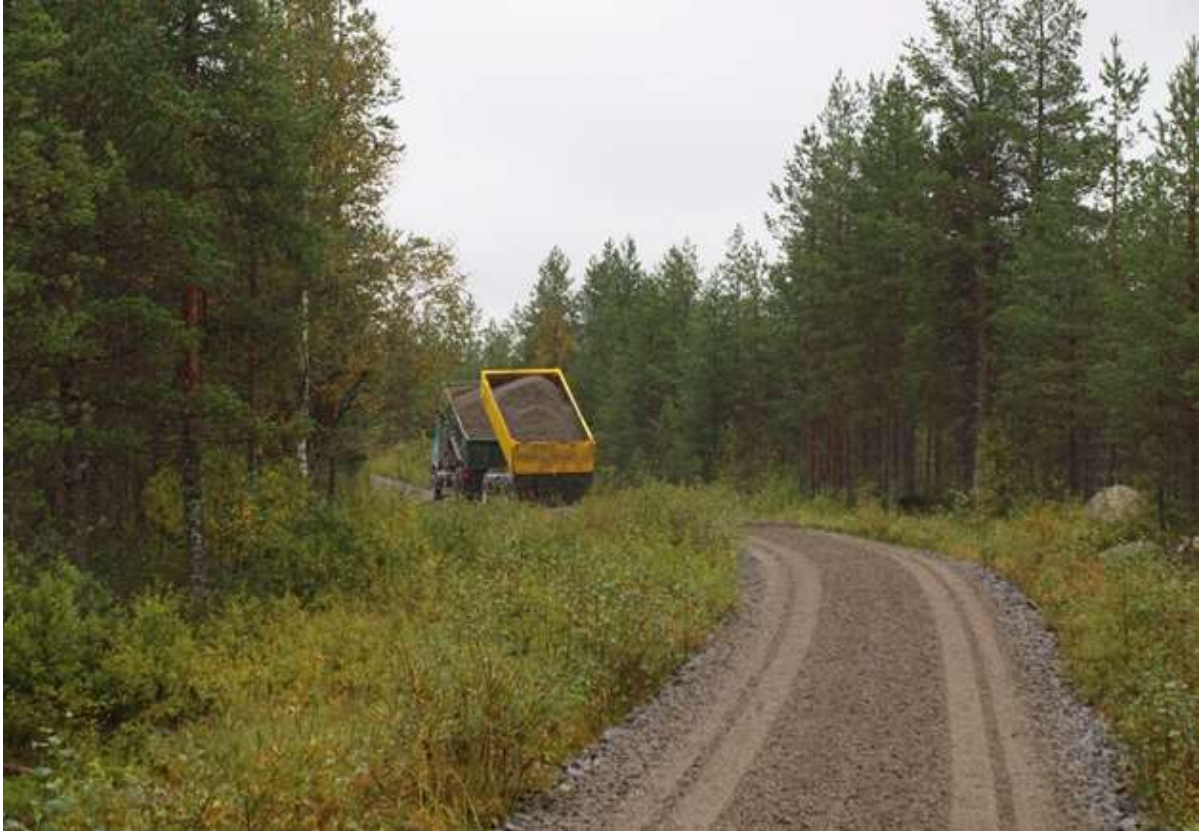
Kuva 9. Pintamateriaalin, tuhkamurskeseoksen, levitys metsätielle. Kuvaaja: Tommi Tenhola.
