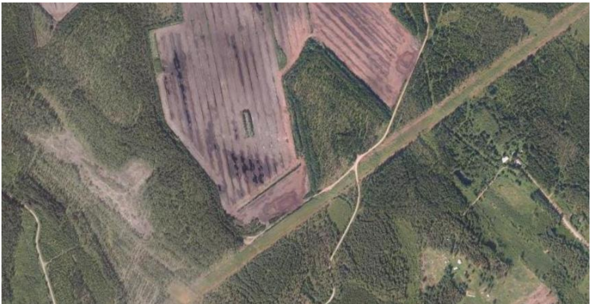
Entiselle turvetuotantoalueelle rakennettava aurinkovoimala sijaitsee 110 kV:n voimajohdon vieressä. Voimalaitoksen tuottama sähkö on tarkoitus syöttää johdonvarsiliitännällä, jonka vaatima sähköasema tullaan rakentamaan aurinkovoimalan eteläreunaan voimajohdon viereen. Kartta: Maanmittauslaitos.
