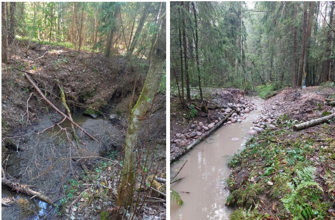
Myllyojan sivupuron sortunut ja eroosiota aiheuttanut rumpu ennen kunnostusta (vasen kuva). Rumpu poistettiin ja alueelle tehtiin kivistä eroosiosuojaus ja samalla virtapaikka (oikea kuva). Kuvat: Jarkko Leka (Valonia).
